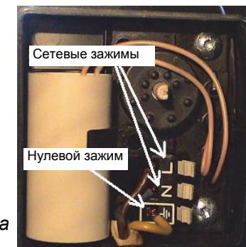
Рис. Подсоединение проводов к насосу Ц.О.
